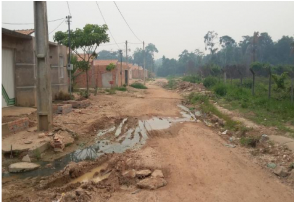
Figura 6 – Situação das vias do Residencial Tiradentes
