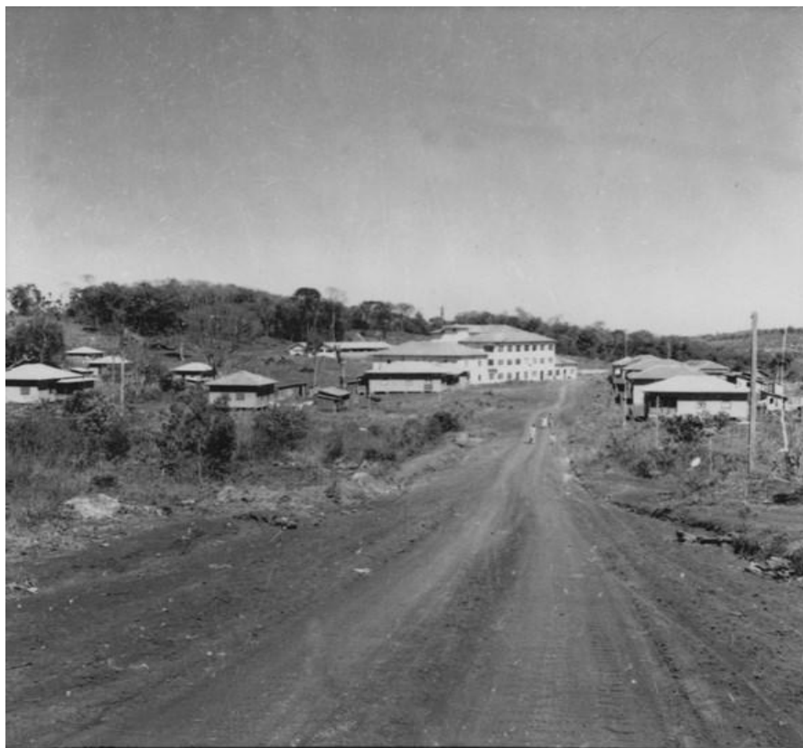
Figura 3 - Vista do Frigorífico de Suínos e as casas operárias no seu entorno em 1957.
