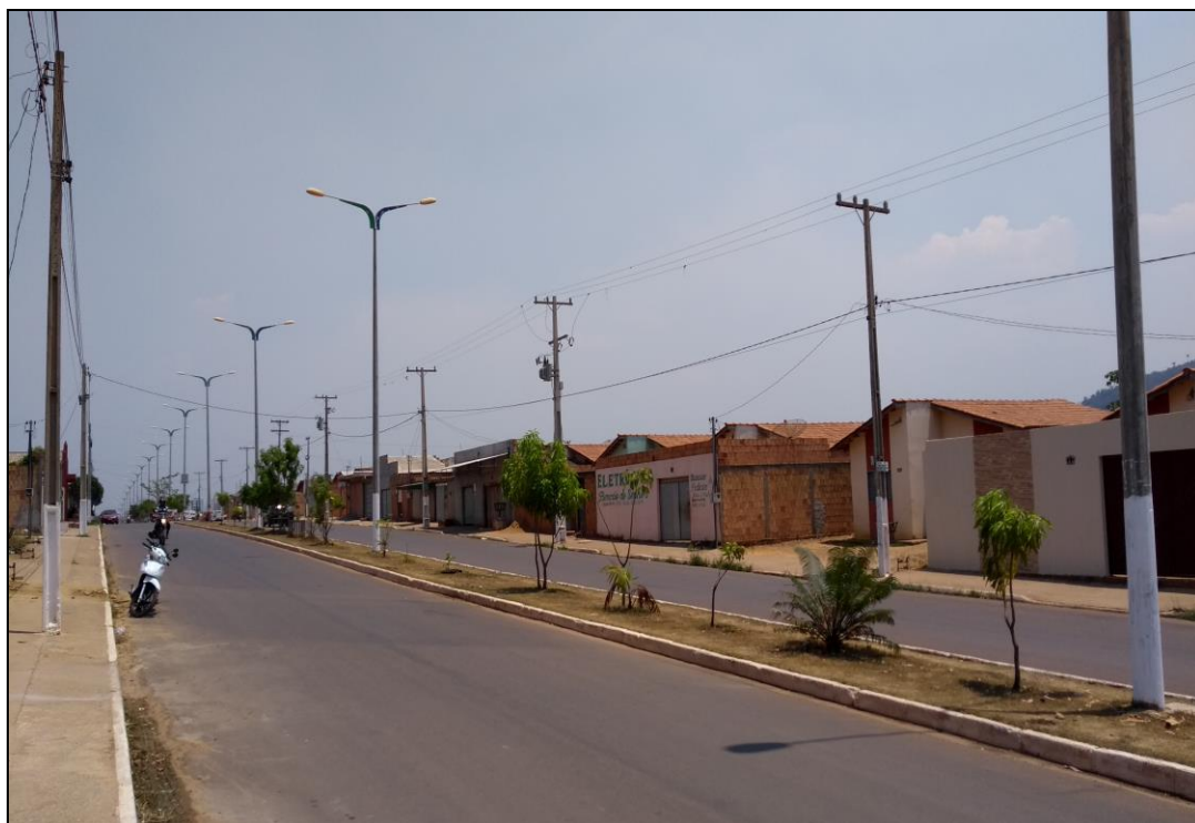
Figura 16 – Aspecto das vias do Residencial dos Minérios (2018)
