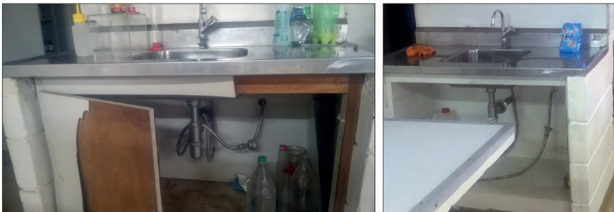
Figura 1: Estados de conservação das pias do laboratório antes (esquerda) e após (direita) a reforma.
