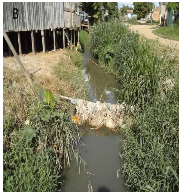
Fotos: A construções dentro da APP, contribuindo para a compactação do leito do canal e foto B compactação do solo, estreitamento do leito, construções na APP e acumulo de sedimentos e material orgânico e inorgânico. (Arquivo pessoal)
