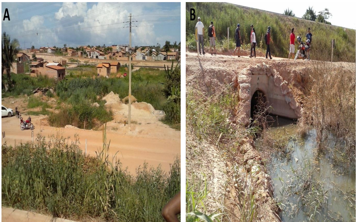
Fotos A, nascente oalmene modificada por ação anropica, foto B bueiro que atravessa a linha ferrea com diametro insuficiene no escoamento da bacia, (arquivo pessoal)
