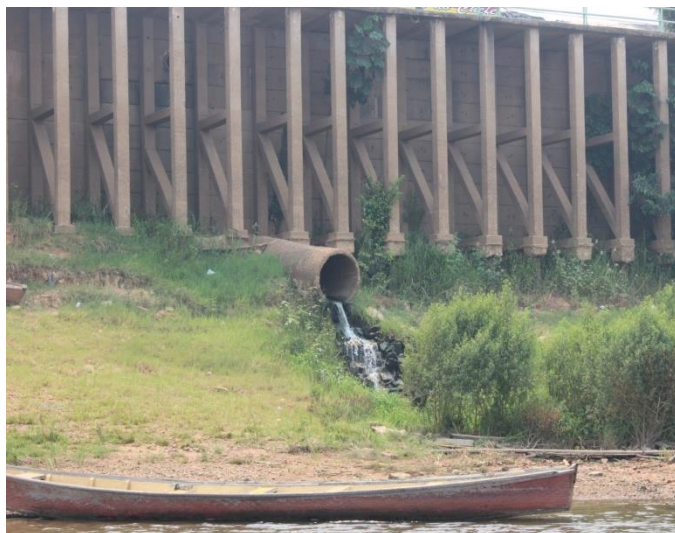
Figura 11 - Esgoto despejado próximo ao leito do rio Tocantins.
