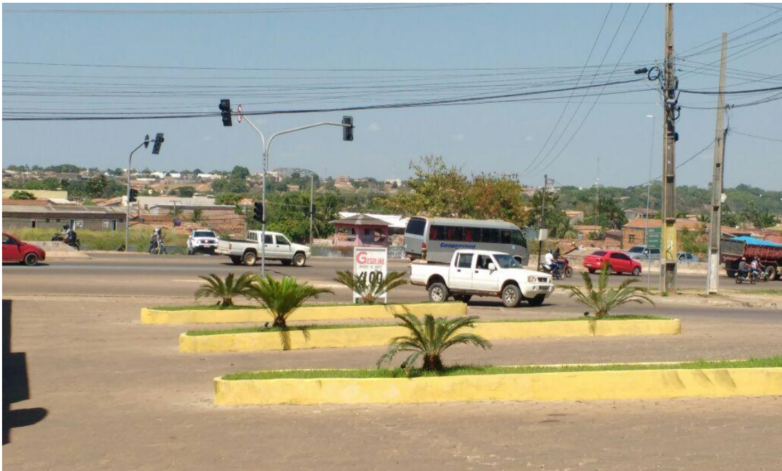
Figura 5: Trevo de acesso à Rodovia, como de fato foi executado e construído
