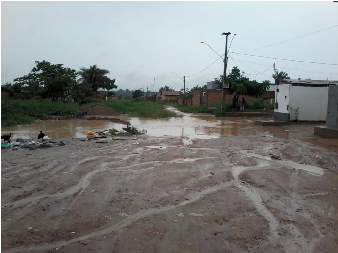
Figura 10: Vista parcial da Avenida Minas Gerais, alagada após uma breve chuva, São Miguel da Conquista, Marabá (PA), 2016.
