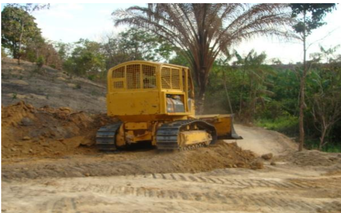
Foto 01 – Trator abre estrada ao lado do Córrego dos Pebas. Fonte: Júlia Freitas, 2009.
