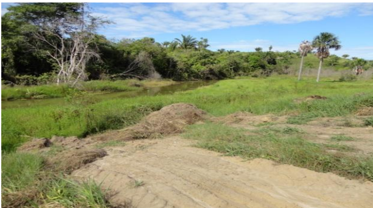
Foto 03 – Entulhamento mecânico feito à margem esquerda do Córrego dos Pebas, no Bairro Novo Horizonte.
