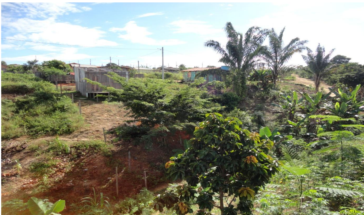
Foto 08 – Casas construídas em terreno irregular e embargadas pela Secretaria do Meio Ambiente de Rondon do Pará.
