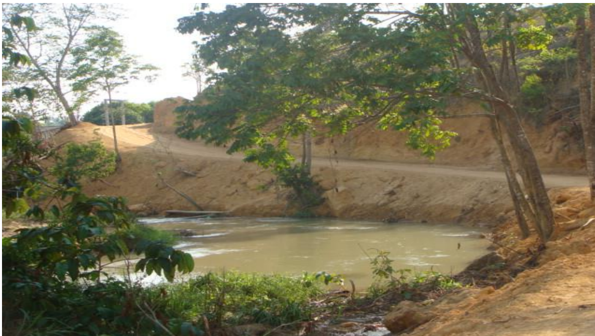
Foto 02 - Estrada aberta ao lado do Córrego dos Pebas.
