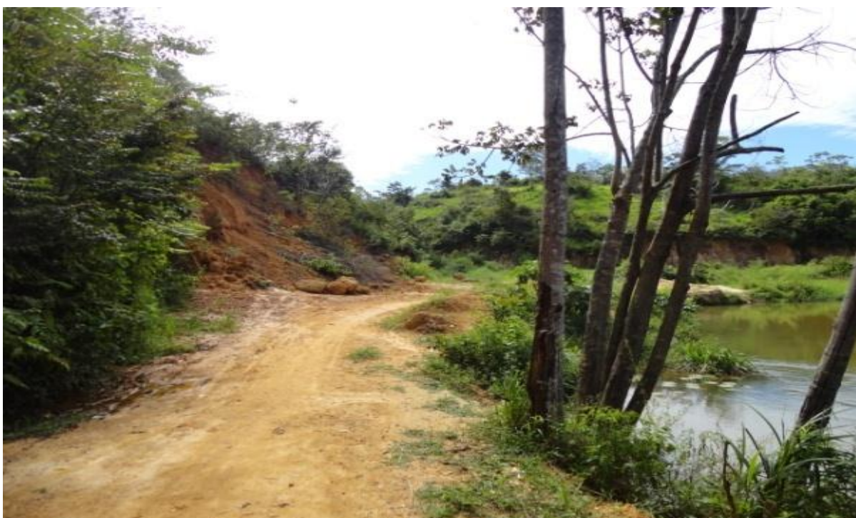
Foto 13 - Deslizamento de terra à margem esquerda do Córrego dos Pebas no Bairro Novo Horizonte em Rondon do Pará.
