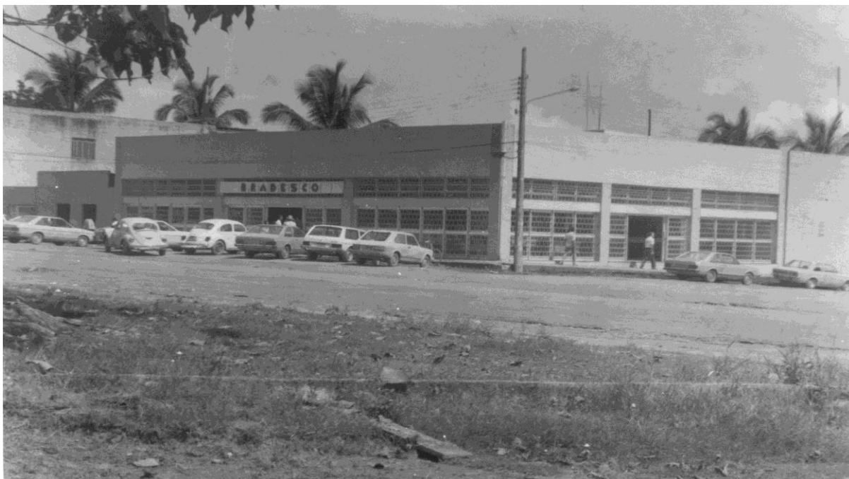
Figura 05- Agência do Banco Bradesco de Rondon do Pará.
