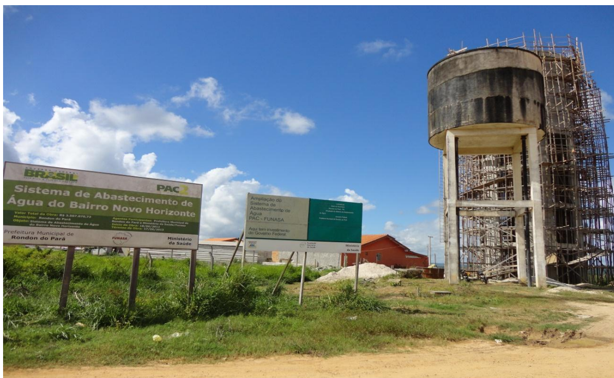
Foto 09 – Construção da caixa d'água para abastecimento de água do Bairro Novo Horizonte em Rondon do Pará – PA.
