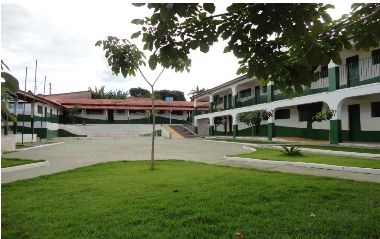
Foto 14- Escola Municipal de Ensino Fundamental Adolfo Soares de Moraes após reforma em 2012.
