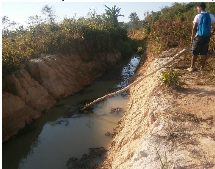
Figura 17 - Rompimento da borda do rio para esvaziamento hídrico das cavas de extração de argila.
