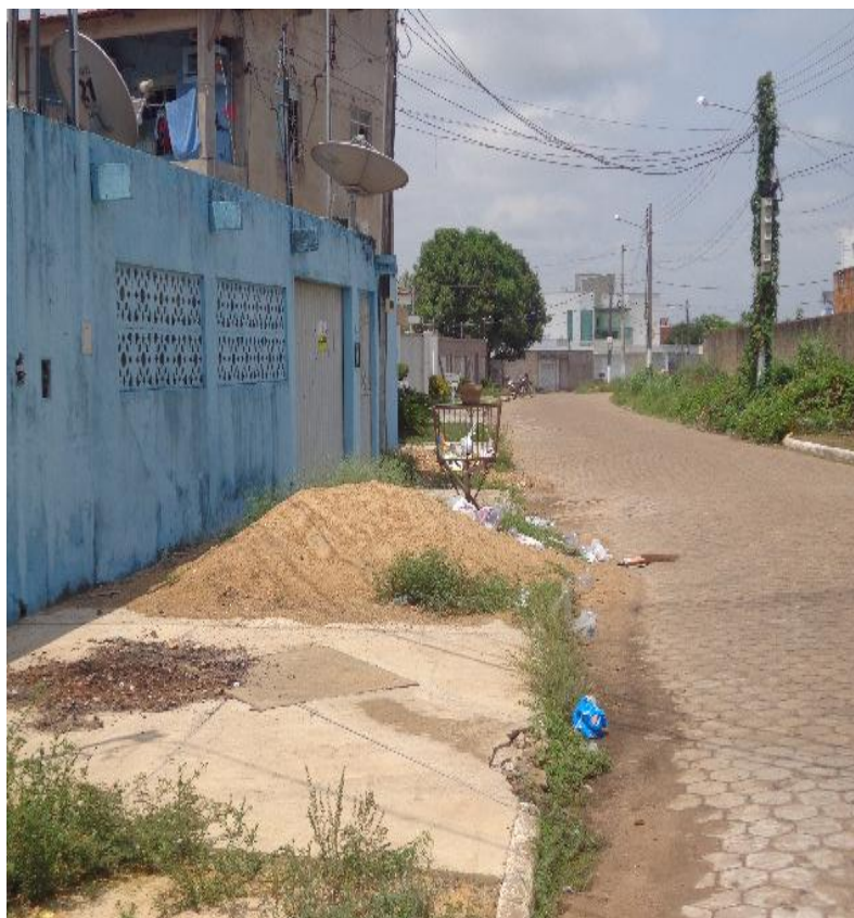
Figura 17: calçadas interrompidas por materiais de construção, etc.
