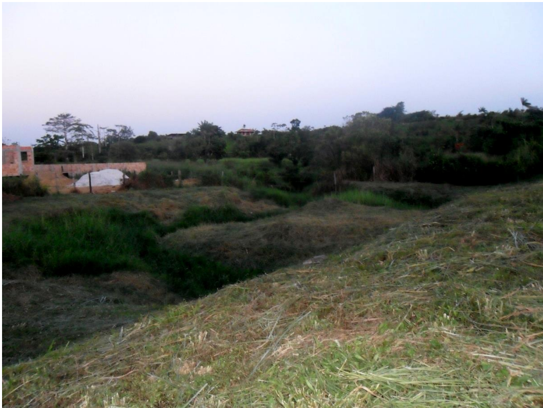
Figura 14: Supressão de parte da mata ciliar no rio Curi e a presença da construção de uma Creche.
