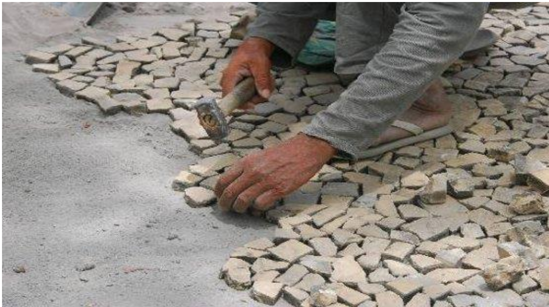
Fotos 3- calçada sendo recuperada – Fonte: Portal Mobilize,2015
