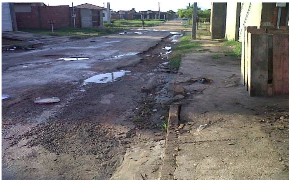
Figura 2: Calçadas e ruas do Residencial Tocantins
