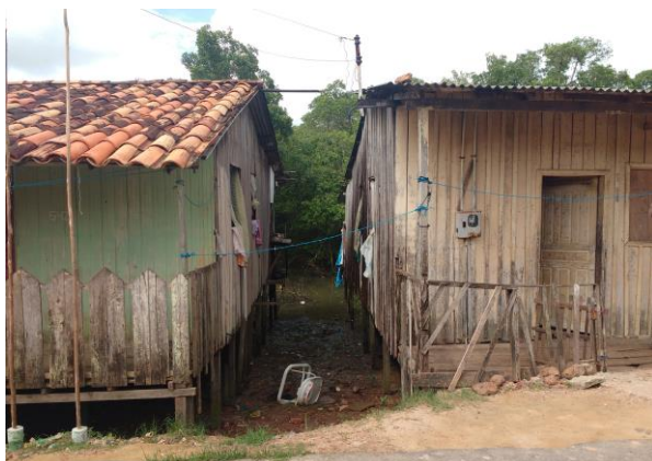
Figura 16 – Planície fluvio-marinha com residências e ponte.
