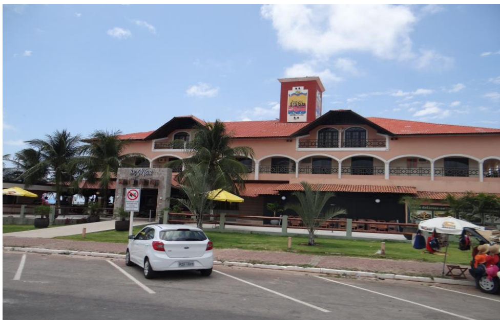
Figura 18 – Hotel localizado sob a unidade tabuleiro.
