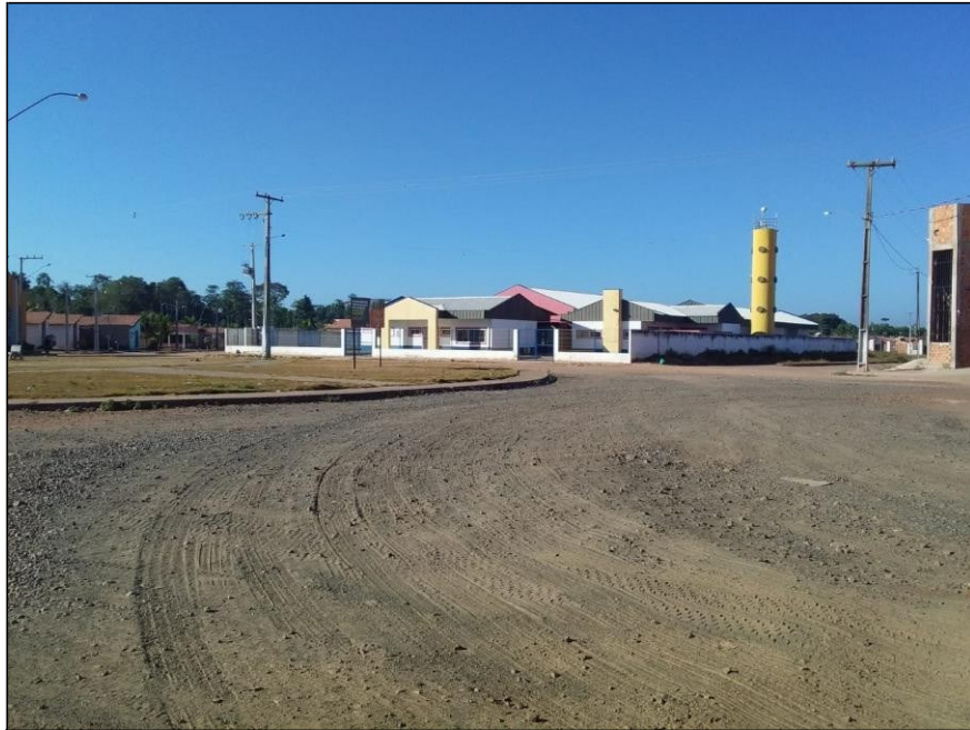
Figura 06- Creche do Residencial Tiradentes
