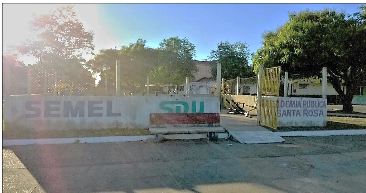
Foto 10: Complexo poliesportivo: academia pública localizada na praça do pescador na Z-30, no bairro da Santa Rosa, no início da infraestrutura física da orla, no núcleo da Marabá Pioneira (Fonte: SILVA, 2017).
