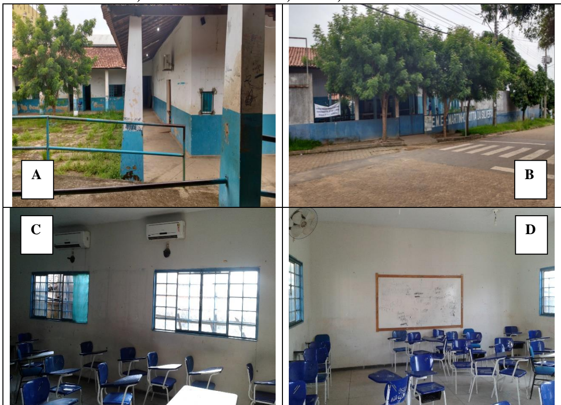
Figura 2 – Aspectos gerais da Estrutura Física da escola em a) ver-se os corredores da escola. Em b) a entrada central em c) e em d) as salas de aula da escola.
