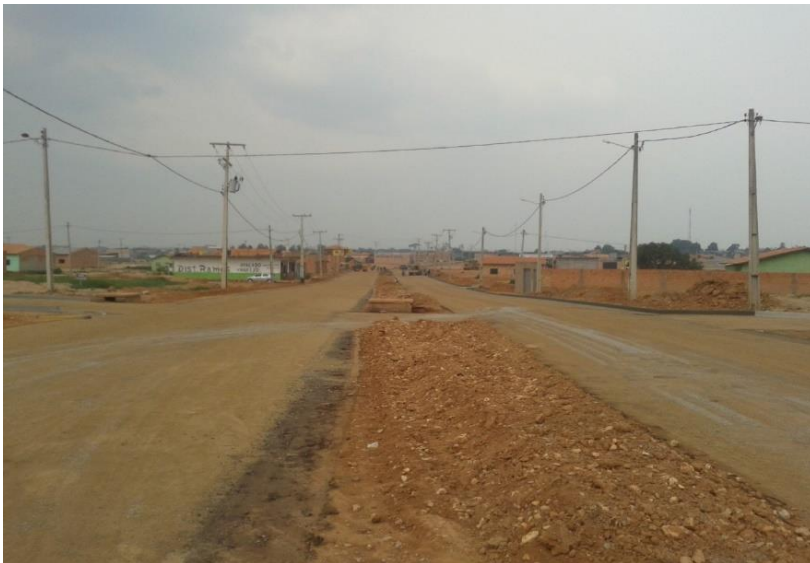
Figura 4, 5 e 6: O asfalto frio sendo posto na Av. Açai no Loteamento Vale do Tocantins no ano de 2015 e na foto 6 condição atual.
