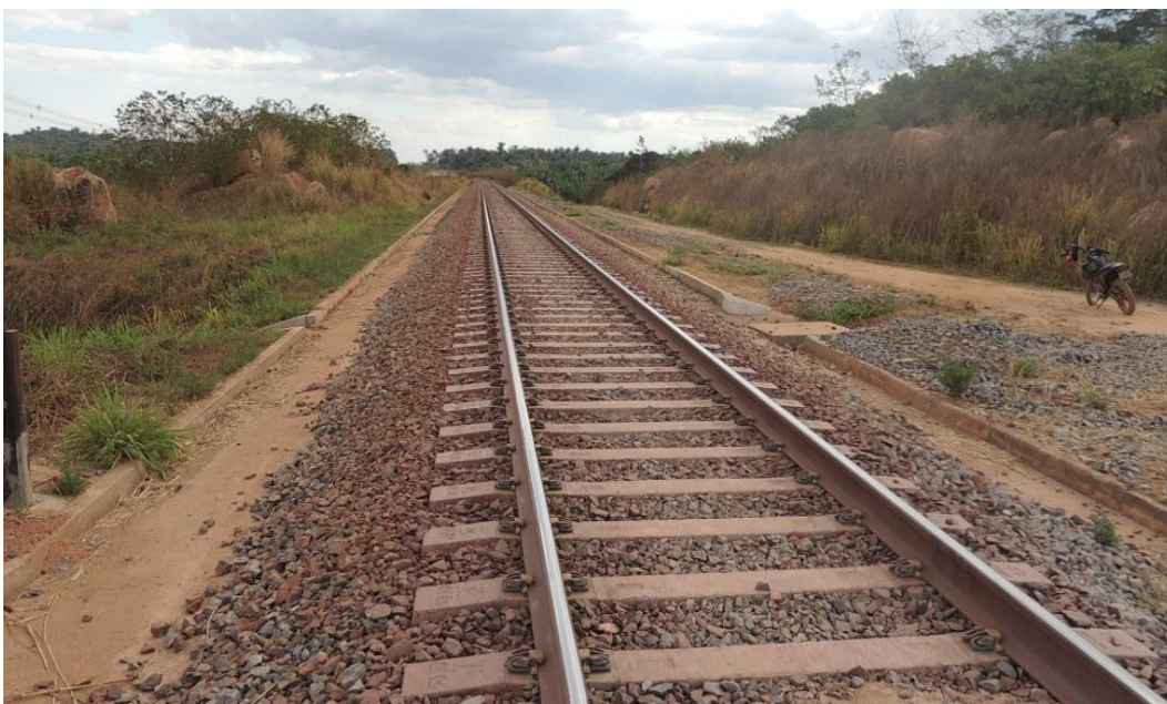
Foto 08 - Ferrovia para exportação de minérios da S11D
