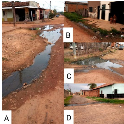
Figura 16 – Esgoto à céu aberto próximo das residências no Bairro Liberdade
